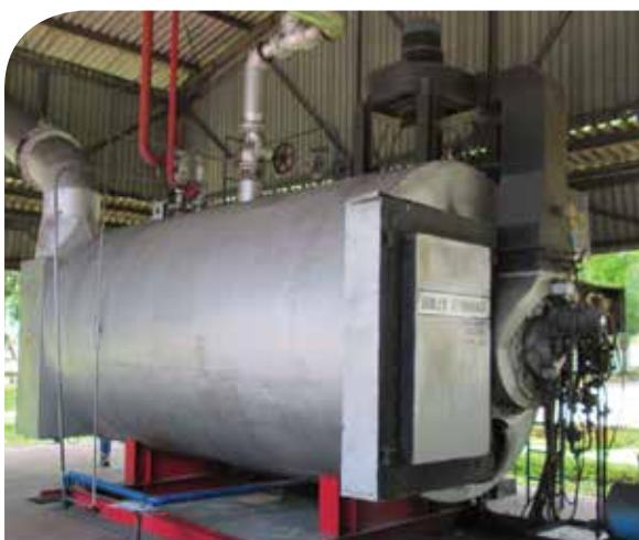
E. FIRE TUBE BOILER (PACKAGE BOILERS)
