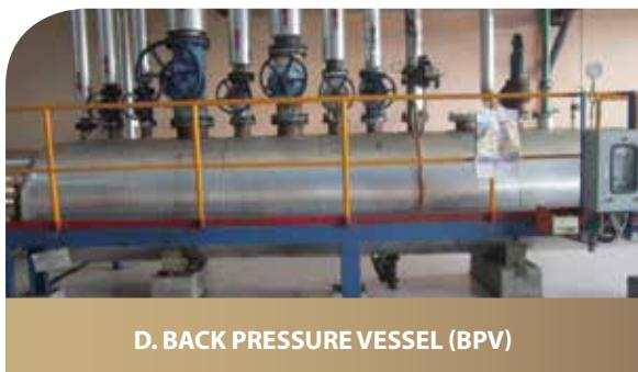
BPV di desain dengan baik dan kualitas pekerjaan yang sesuai dengan *standard pressure vessel*. BPV digunakan sebagai penampung *exhaust steam* (*steam* buangan yang berasal dari turbin) untuk disalurkan ke unit-unit proses.
