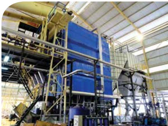
**B. WATER TUBE BOILER – SOLID FUEL
